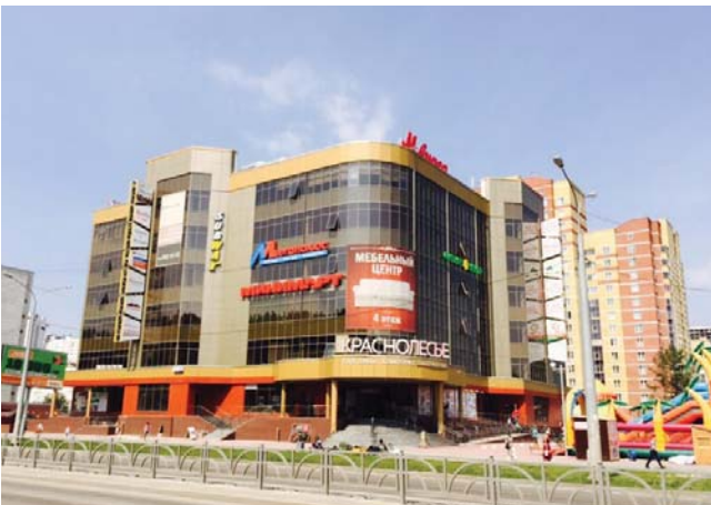
ТОРГОВЫЙ ЦЕНТР «КРАСНОЛЕСЬЕ» Екатеринбург, 700 квТ
