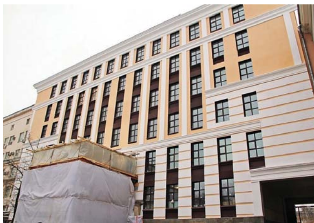
БИЗНЕС-ЦЕНТР «БАСМАНЫЙ ПАРК» Москва, 495 кВт
