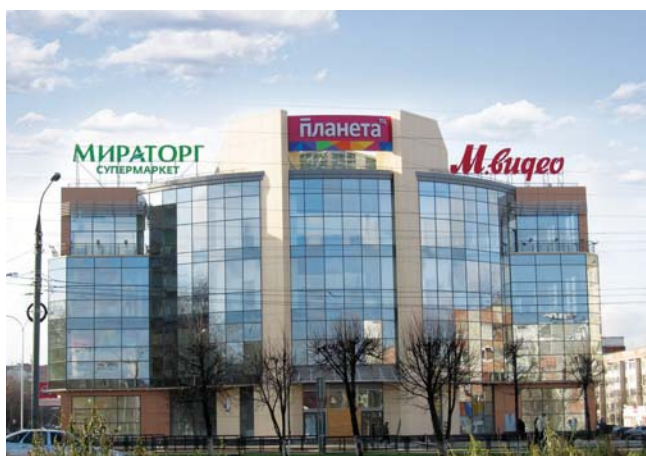
ТОРГОВЫЙ ЦЕНТР «ПЛАНЕТА» Йошкар-Ола, 836 квТ
