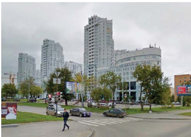
БИЗНЕС-ЦЕНТР «ТАТИЩЕВСКИЙ» Екатеринбург, 500 кВт
