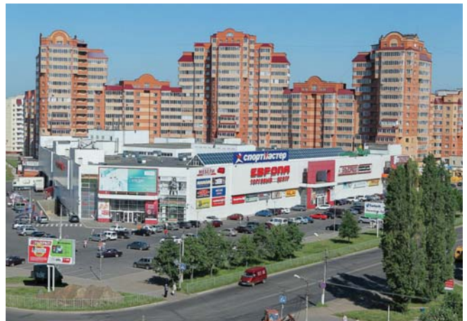
ТОРГОВЫЙ ЦЕНТР «ЕВРОПА 26» Железногорск, 320 квТ
