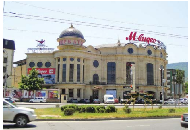
ТОРГОВЫЙ ЦЕНТР «МИРКАТО» Махачкала, 590 квТ
